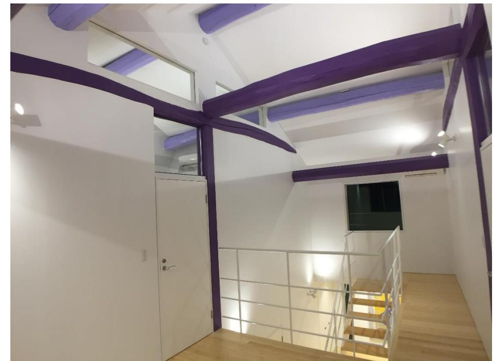
1・2階 階段ホール 内部コミュニケーションスペース。壁；AEP塗装白 床；竹フローリング 茅葺時代の墨色梁は紫色に、切妻時代の白木の棟木は藤色とし、古民家の記憶を抽象化した。階段ホール両サイドの壁が2層にわたる南北方向の構造壁となる。
