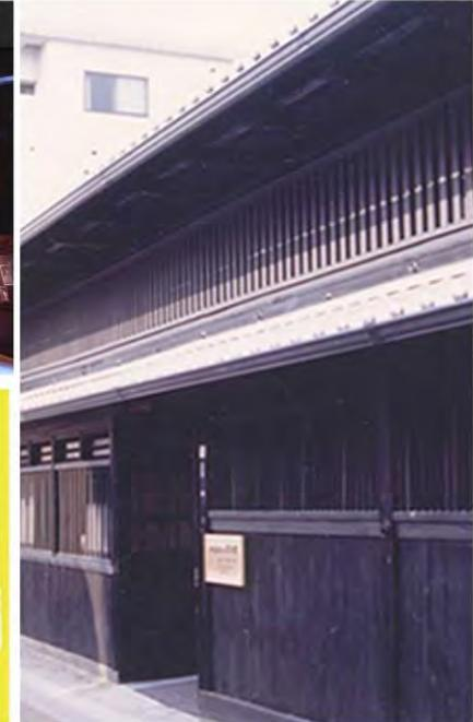
奈良市鶴町、通称奈良町に位置する。約150年前より、商家として利用されていた町屋の資料館としての再生である。現況建築の木軸組みを強調させるため、既存の内部こまい壁、建具はすべて撤去し、その分の構造負担を外壁、屋根、2階床に新たに構造用合板を加える事により、構造的強化を行った。また内部のシンボル的な4本の柱に囲まれたコアに強化ガラスを入れ、構造補強をすると共に、資料館としての象徴的なスペースとした。また、解体した建物の廃材を階段や家具などに可能限り、再利用した。現代的な観点で新しく手を加える事により建築は次世代に継承されると考えており、今回は存在感ある古典的軸組に、透明感あるガラスという異質な新しい素材を重ね合わせることにより、木軸組の意味を問い直し、古い建築の蘇生を試みた。約150年間にわたる伝統、歴史、人の記憶を継承しながら、建築が生まれ変わり、生き続ければと考えている。
