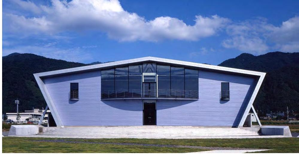
プライダルメーカー「アルファブランカ」の複合施設である。X形のユニットは、屋外空間ではH鋼のフライングバットレスをもつオーバーハングした壁面を、内部空間では上部に開かれた逆台形の断面を持つ浮遊感のあるスペースを構成する。単純な形式の構造フレームの反復により内外空間の形成を試みたものである。将来はこの第2期施設と同形式の教育施設や文化施設をつくり、地域への貢献を進めていきたい。
