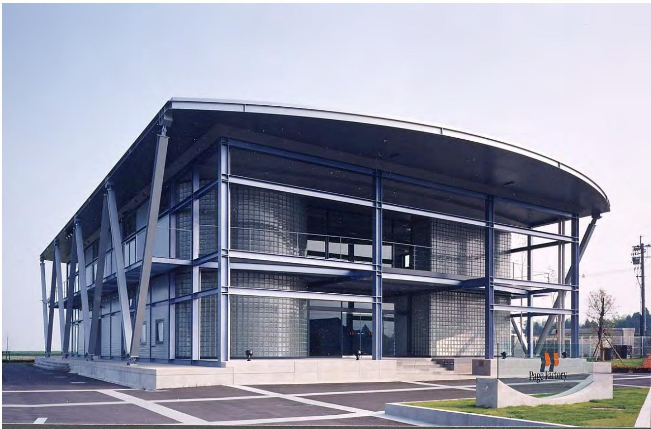
宮崎県に竣工した、印刷会社の編集のためのコンピュータセンターである。晴れ、雨、降灰と、天候の変化の大きな土地であるため、建物は快適な環境をつくり出すための大きな屋根を持つ。無機質な素材であるH鋼の形態的操作を通じて、地域環境のインフラストラクチャーとも言える形式を内包させようとした。角度を持ったブレースは田園風景を強調し、約30km離れた霧島連邦と呼応する。地域環境が地域景観に転換することを期待した。
