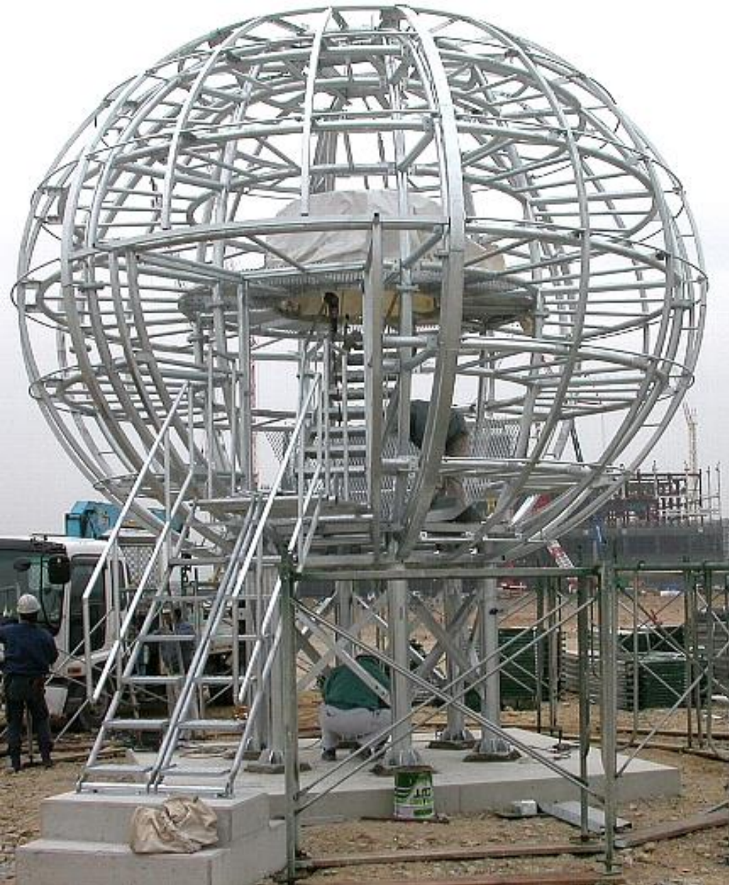
SEASIDE FARM2005 自立する鉄骨構造
